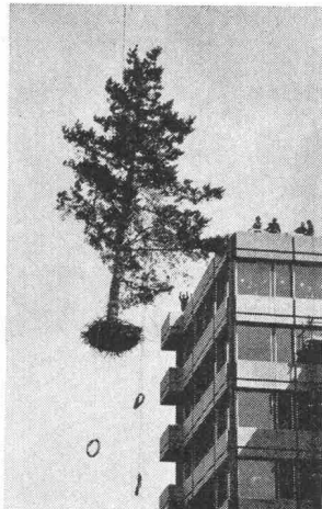
Versetzen von Bäumen
