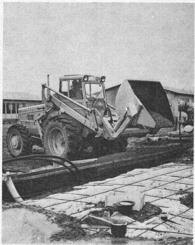
Er transportiert Fertigbeton und Kies.
