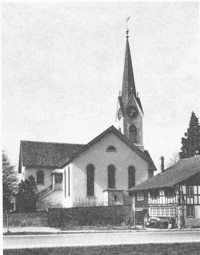
Bild 11. Dübendorf, ref. Kirche «im Wil». Um- und Erweiterungsbau 1833–34 von Heinrich Bräm (1792–1869). Dachreiter von 1870. Abgebroschen 1969
