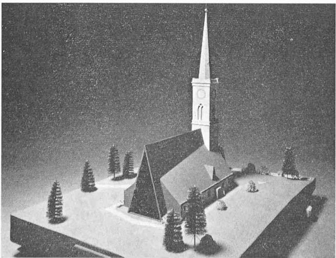
Bild 24. Das Modell zeigt die neue gebrochene Dachkonstruktion mit dreieckiger farbiger Kunstglaswand als Chorabschluss
