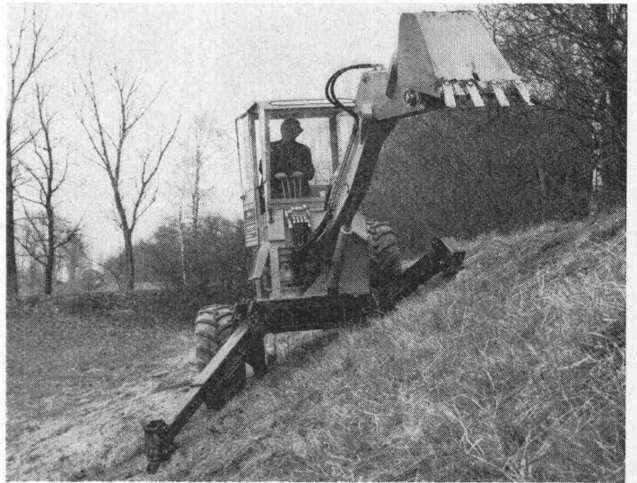
Bild 1. Der Menzi-Muck-Bagger ist bereit für die Arbeit am Hang
