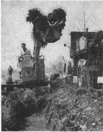
Arbeit mit dem Grabenlöffel
