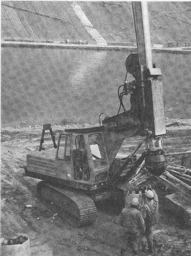
Bild 1. JCB-Bagger Typ 7C mit angebauter Tiefschachteinrichtung
