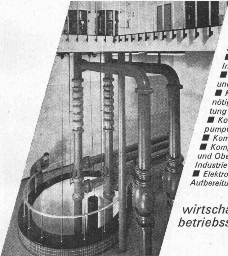
Grundwasserpumpwerk mit Sulzer-Bohrlochpumpen und einer Entkeimungsanlage durch Ozon
