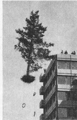
Versetzen von Bäumen
