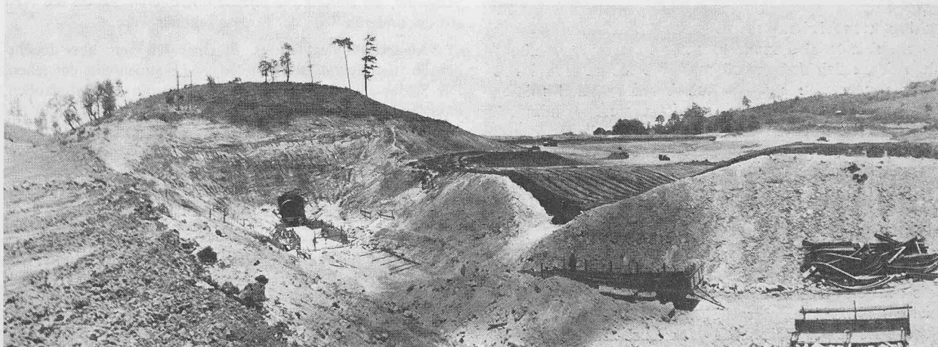
Bild 4. Baustelle am Wasserkraftwerk Rio Lindo in Honduras
