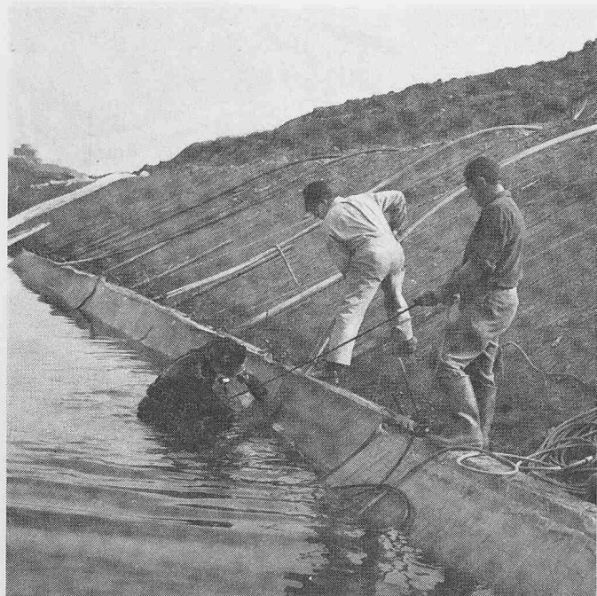
Bild 14. Anwendung von Dichtungsmatten in Belgien
