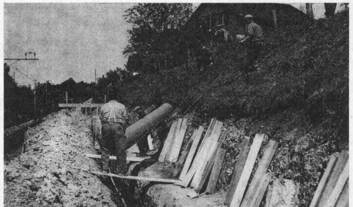
KALIDUR-Kanalisationsrohre, verlegt im Bahneinschnitt
