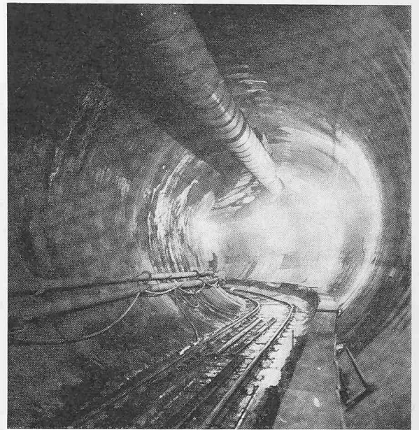
Bild 7b. Unterer Zufahrtstollen, 7. Januar 1971
