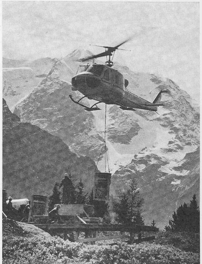
Der Hubschrauber Augusta Bell 204B bei der Versorgung einer Baustelle mit Frischbeton
