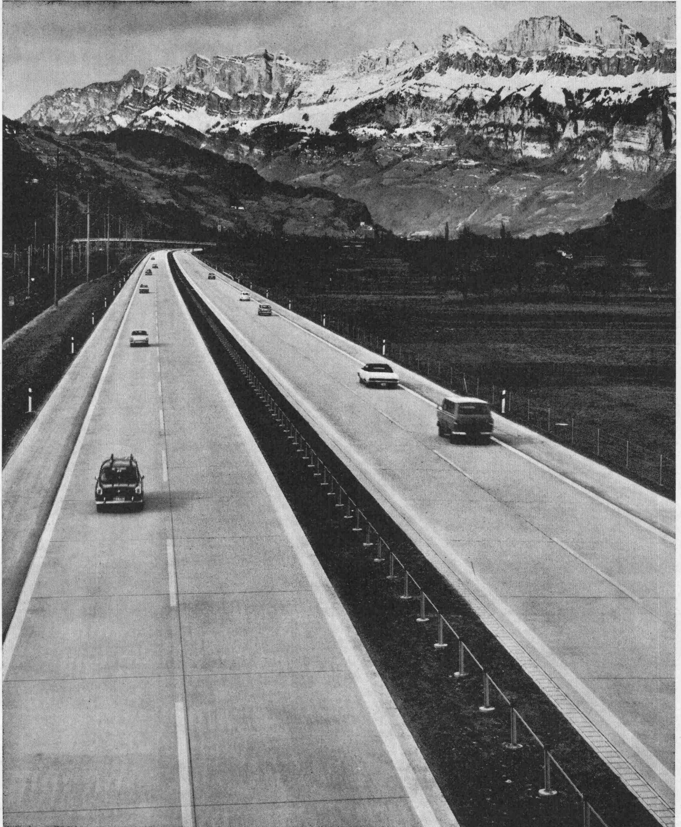
Nationalstrasse N 3 Zürich—Chur, Teilstrecke Flums—Mels, Betonbelag
