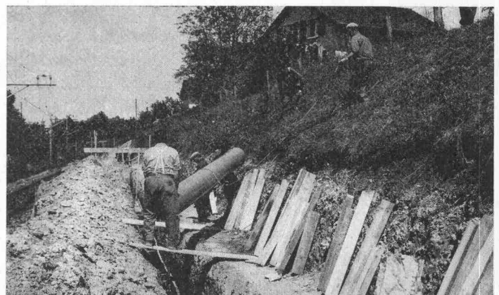
KALIDUR-Kanalisationsrohre, verlegt im Bahneinschnitt
