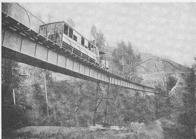
Bild 4. Schnurtobelbrücke im Originalzustand. Dampflokomotive mit stehendem Kessel
