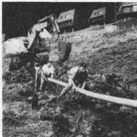
Kanalisation Schwyz: Rothenturm
