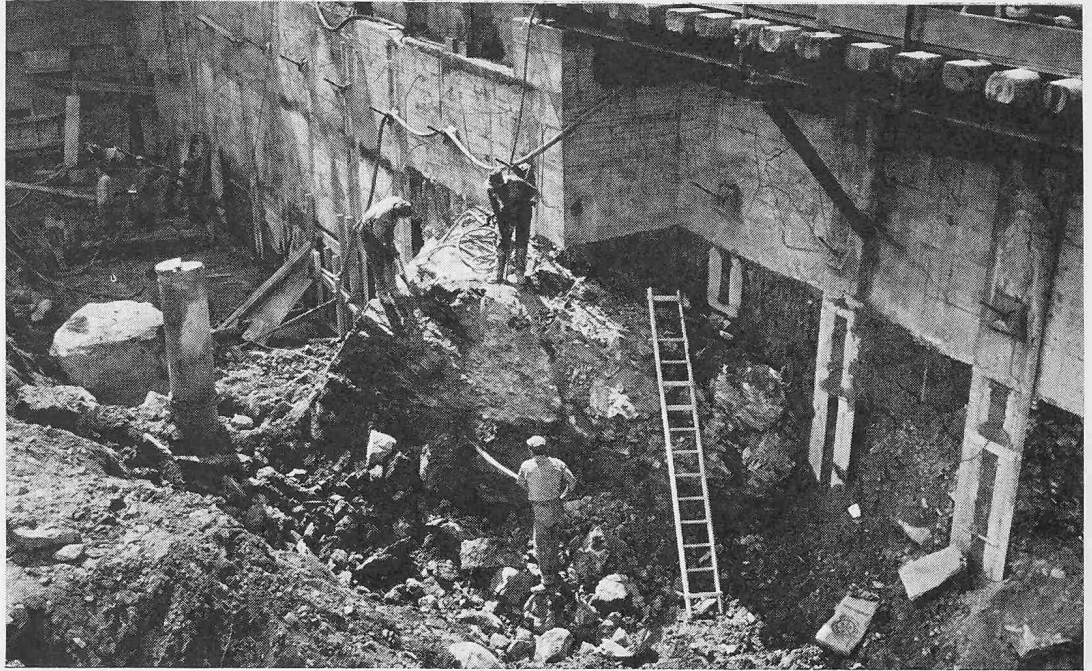
Bild 2. Findling in der Baugrube; Ankerköpfe der oberen Lage der Erdanker
