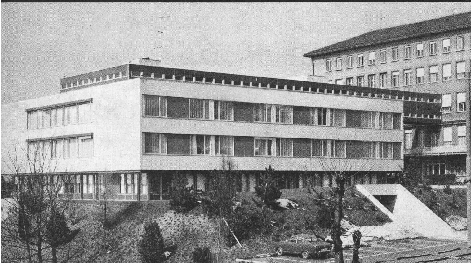
Kantonsspital Lausanne Anbau Chirurgietrakt Architekten: HH. P. Bonnard, J.P. Cahen, J. Lonchamp, Lausanne
