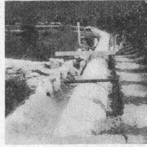
Kanalisation im Wallis
