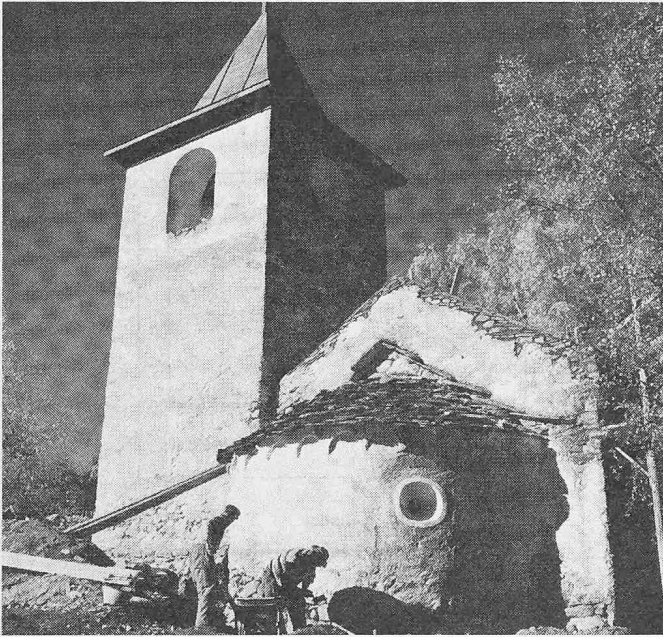
Das Hügelnkirchlein von Casti stammt aus romanischer Zeit (12. Jh.). Die bitter notwendige Restaurierung ist im Gange, erfordert aber noch weitere finanzielle Hilfe
