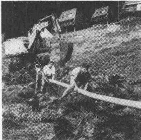
Kanalisation Schwyz: Rothenturm
