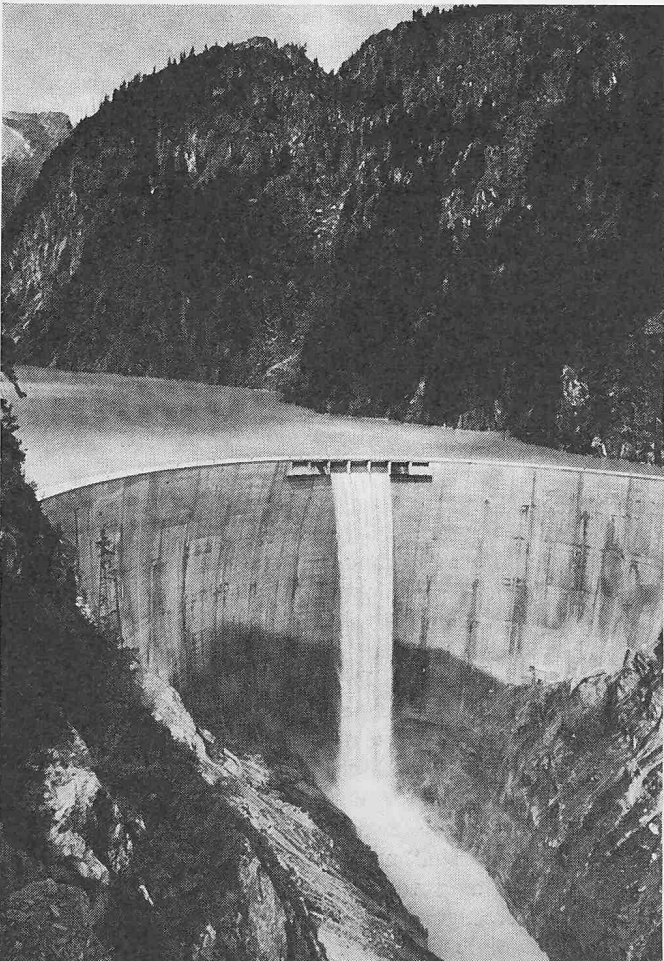
Bild 1. Staumauer im Tal der Massa bei Gebidem oberhalb Blatten
