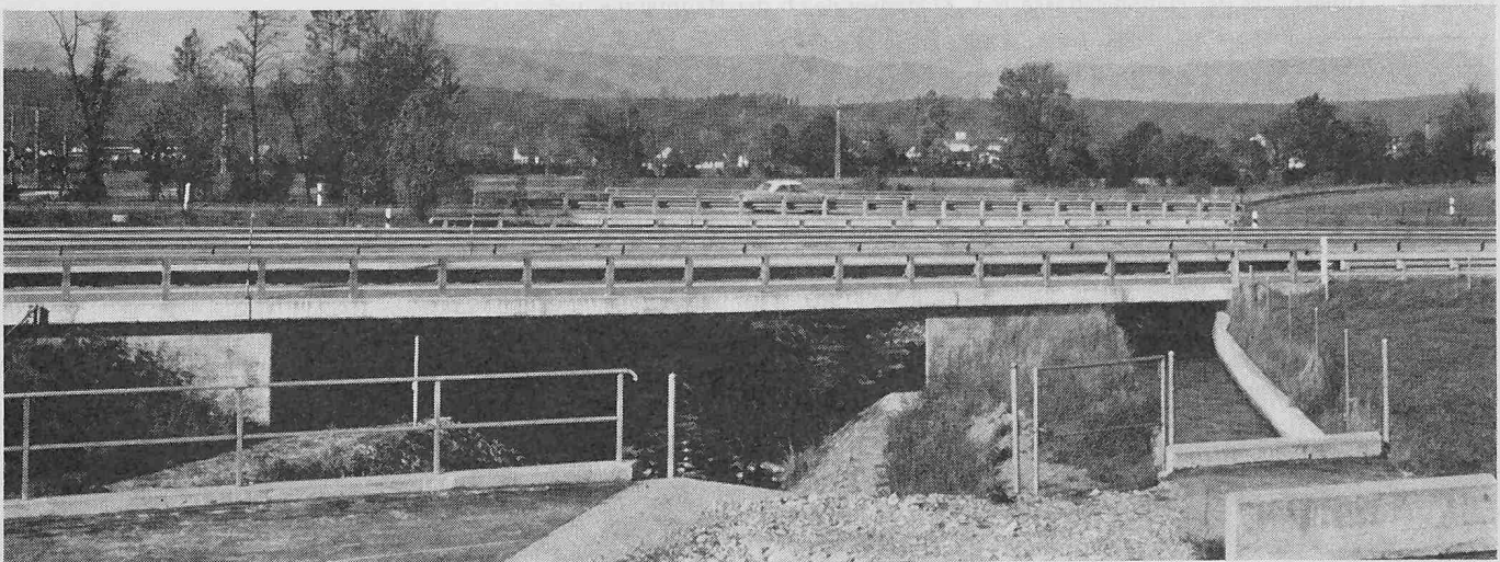
Bild 1. Objekt 208 der Nationalstrasse N 1
