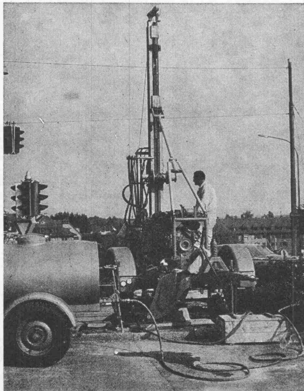
Sondierbohrung Bucheggplatz Zürich
