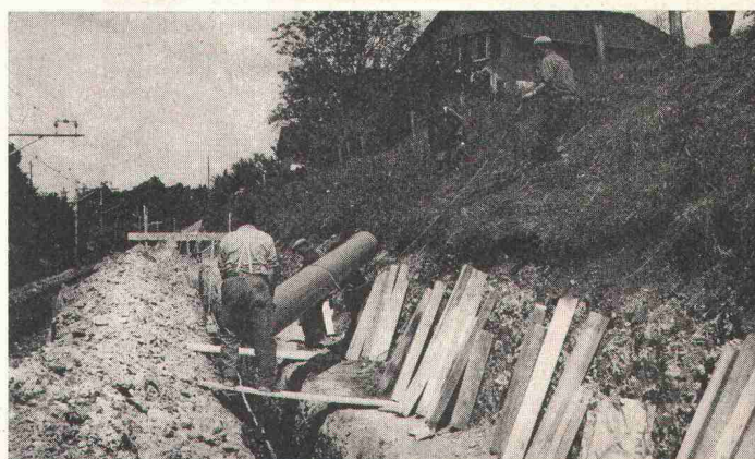
KALIDUR-Kanalisationsrohre, verlegt im Bahneinschnitt
