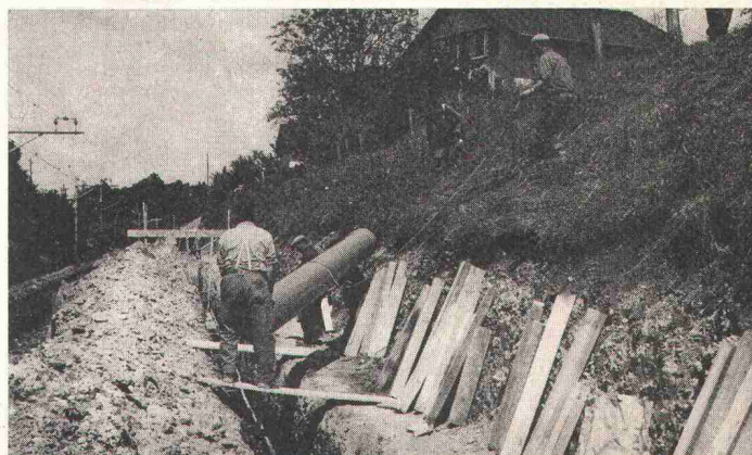
KALIDUR-Kanalisationsrohre, verlegt im Bahneinschnitt
