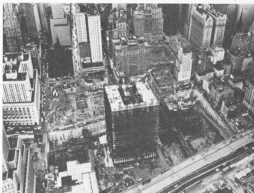
Bild 2. Ansicht der Baustelle. Der Turm rechts folgt mit etwa achtmonatigem Zeitabstand dem linken. Einige der Gebäude im Hintergrund müssen dem Handelszentrum noch weichen
