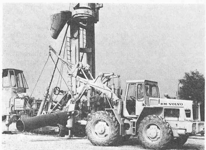
Bild 4. Ein Radlader Typ LM 845 im Einsatz am Flughafen Zürich-Kloten
