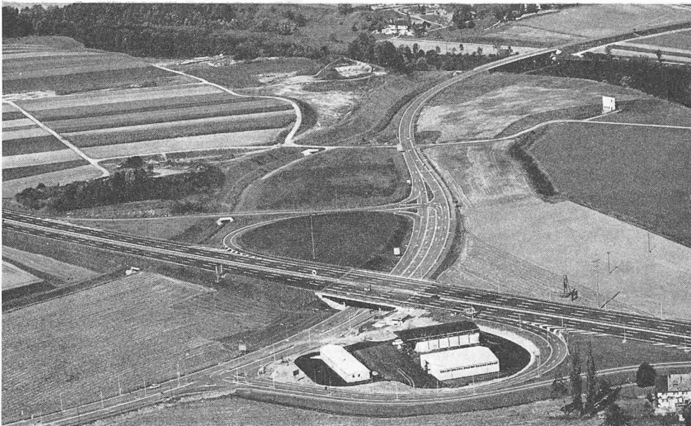
Bild 3. Der Nationalstrassenabschnitt, N 1, Neuenhof-Europabrücke, konnte am 15. Oktober 1971 dem Verkehr übergeben werden. Anschlussbauwerk Oetwil a. d. L.-Dietikon/Spreitenbach mit Werkhofprovisorien; im Hintergrund die Limmat
