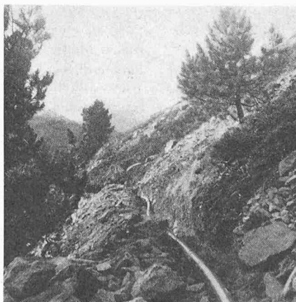
Bild 2. Der offene Graben mit eingelegter Weichpolyäthylenleitung. Alp von Gspon
