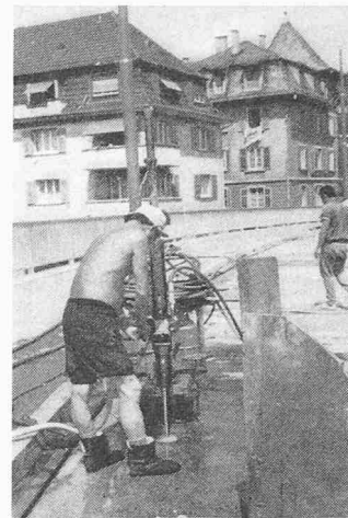
Bild 12. Einsatz einer Rotations-Kernbohrmaschine bei der Sanierung einer Brücke
