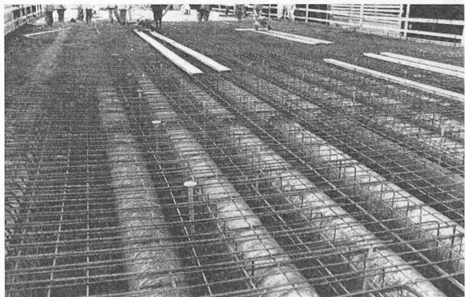
Bild 7. Zum Betonieren vorbereitete Brückendecke. Zwischen den Bewehrungsseisen sind die Honel-Elemente zu erkennen
