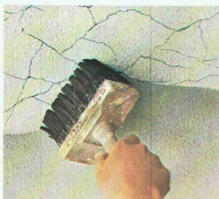
Bei leichten Haarrissen in der Feinputzlage ein- bis zweimal satt Herbol-Imprägniergrund auftragen
