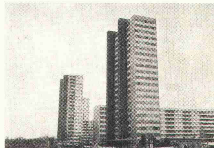
Dichthalten: Tscharnergut, Bern
