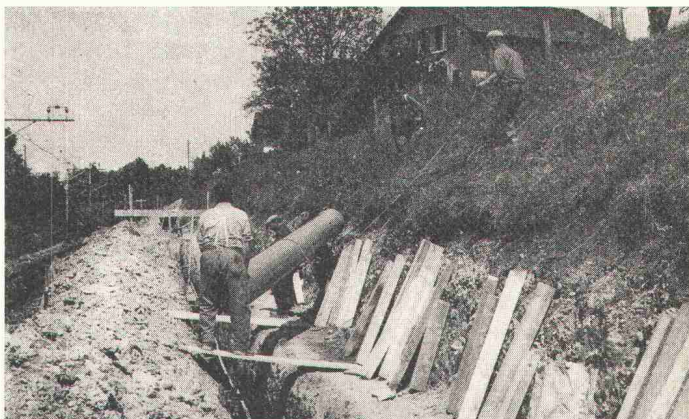
KALIDUR-Kanalisationsrohre, verlegt im Bahneinschnitt
