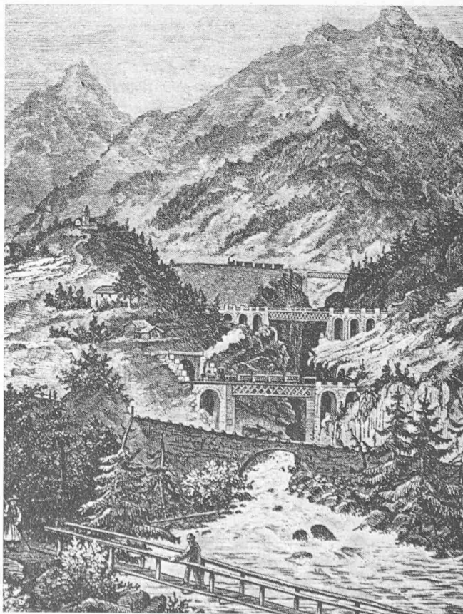
Bild 1. Bahnanlage bei Wassen mit der Strassenbrücke und den drei Eisenbahnbrücken über die Meienreuss (alter Stich)
