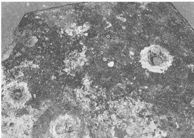
Bild 1. Perforation eines erdverlegten Stahltanks von innen
