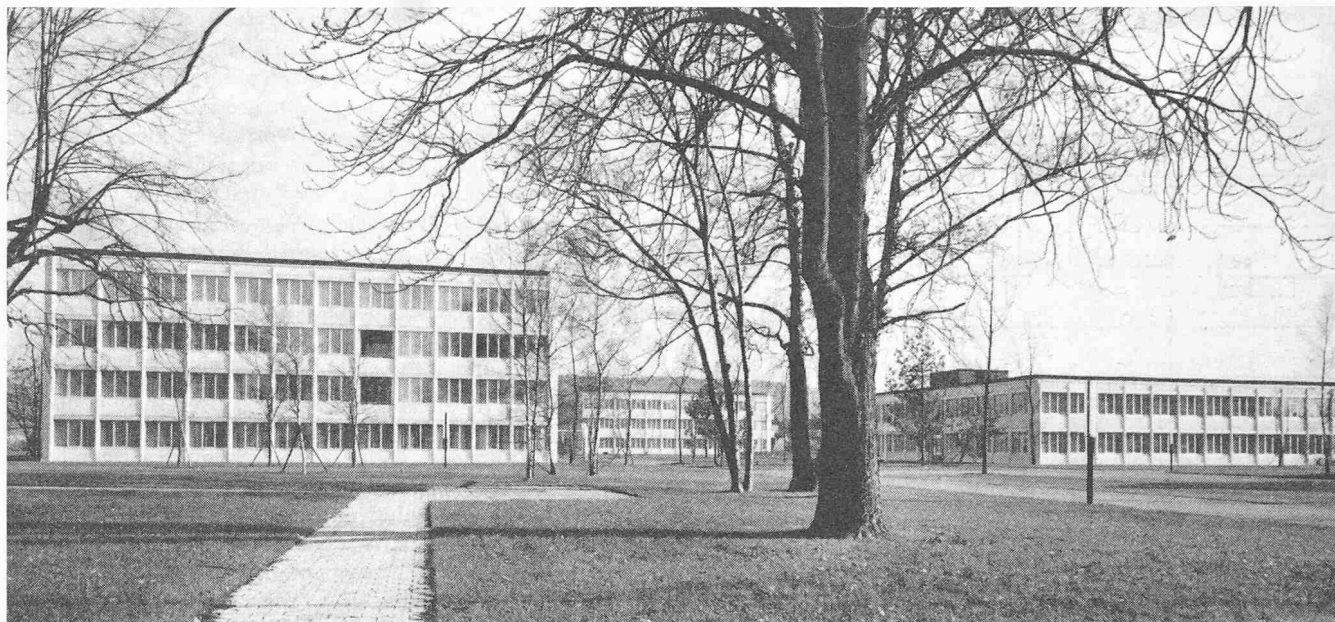
Ansicht der Neubauten gegen Süden. Links P4, rechts P5. Dazwischen im Hintergrund P6
