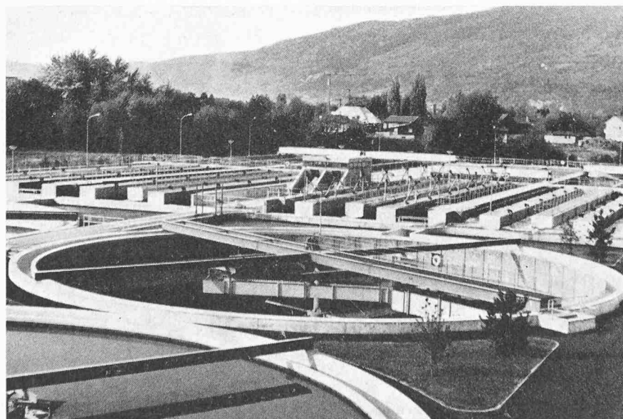
Bild 1. Kläranlage «Müra», Biel
