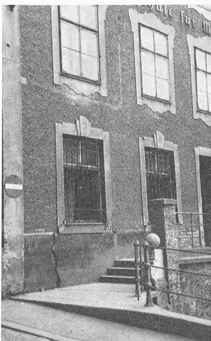
Bild 3. Ungleiche Setzungen am Ursulinen-Kloster
