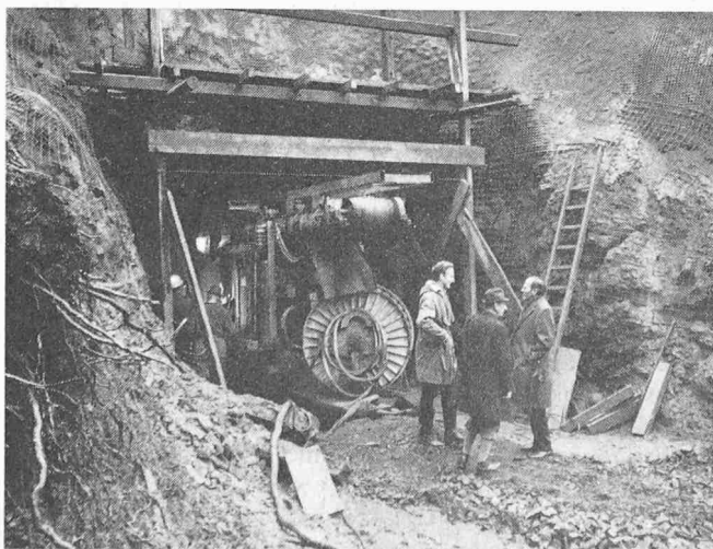
Bild 1. Beginn der Bohrarbeiten für den Sondierstollen Huttegg
