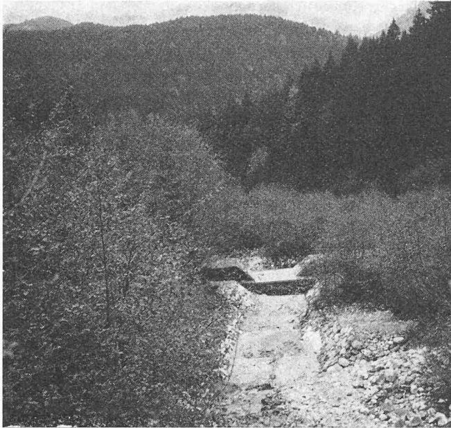
Bild 3. Mit Querwerken, gepflasterter Bachsohle und Grünverbau wird ein Zufluss des Halblech saniert. Die Geländerutschungen sind bereits vermindert worden
