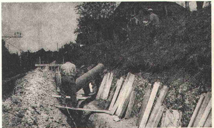
KALIDUR-Kanalisationsrohre, verlegt im Bahneinschnitt
