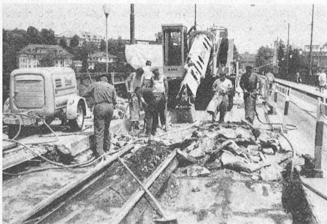
Bild 2. Abbruch der alten Fahrbahn. Stark unterschiedliche Qualität des alten Betons. Zwischen den Schienen verkitteter Kies, daneben Brocken, die normale Festigkeit aufweisen
