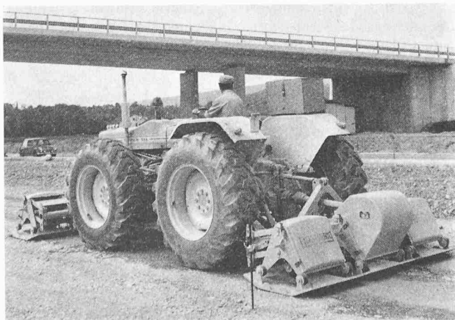
Bild 8. BV-6 an Ford-County: Boschung-Verdichter, zwei Reihen zu je drei Platten
