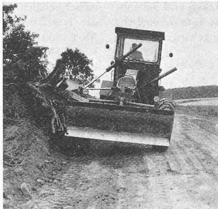
Bild 9. Herausreissen und Abschieben des Stubbens
