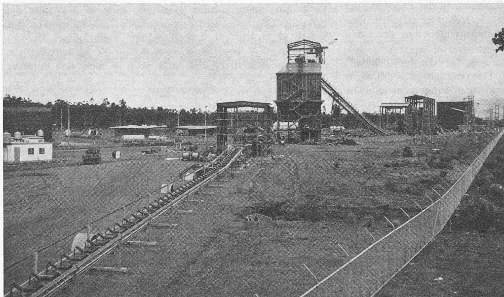
Bild 2. Brecher und Siebstation
