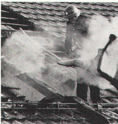
Die Feuerwehr schafft durch Aufreissen des Daches Abzugsmöglichkeiten.
