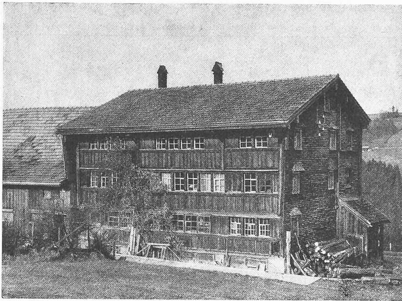
Hundwil. Bauernhaus im Tobel Nr. 72. Mit dem Datum 1568 (1564?) an der Fusspfette; das einzige datierte und überhaupt einzige traufständige Tätschdachhaus («Heidenhaus») von dieser Grösse in Appenzell Ausserrhoden. In Traufstellung angebauter Stadel, 1614 datiert (Abb. 370)
