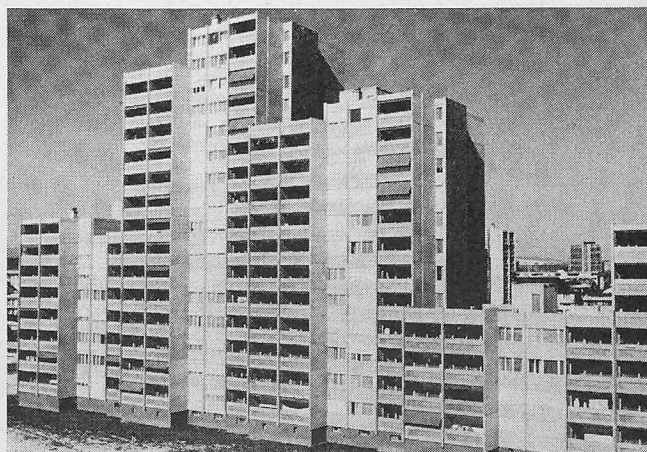
Bild 1. In Grosstafelbauweise vorgefertigte Wohnüberbauung Kleefeld-Ost in Bern
