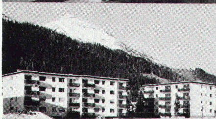
Überbauung Rietstrasse, Elektrizitätswerk der Landschaft Davos; total 33 Wohnungen; Anschlusswert ca. 400 kW
