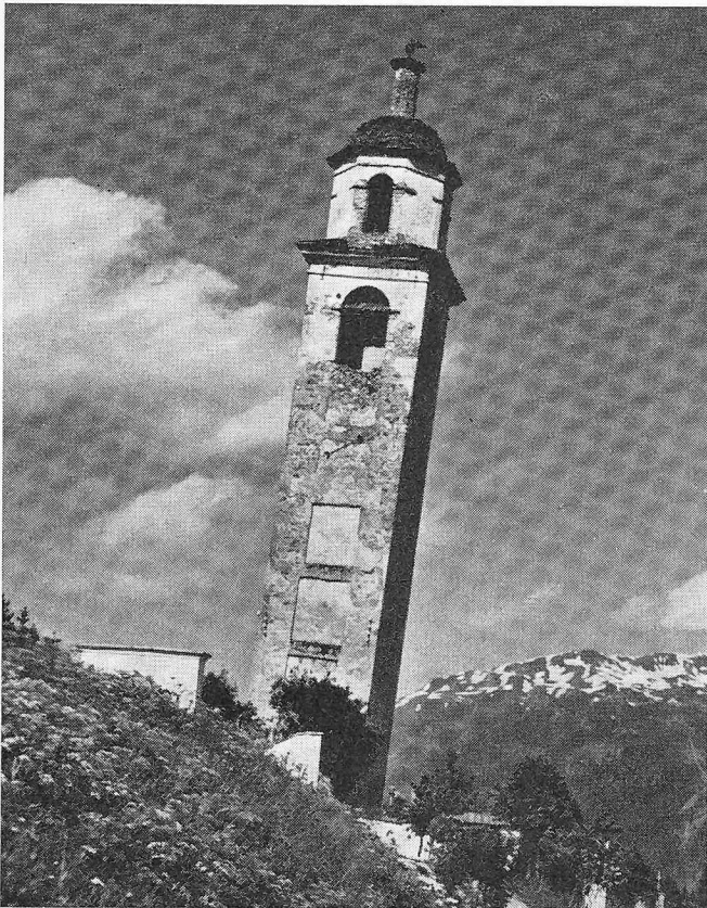
Bild 1, oben. Schiefer Turm von St. Moritz, Ansicht von Westen
